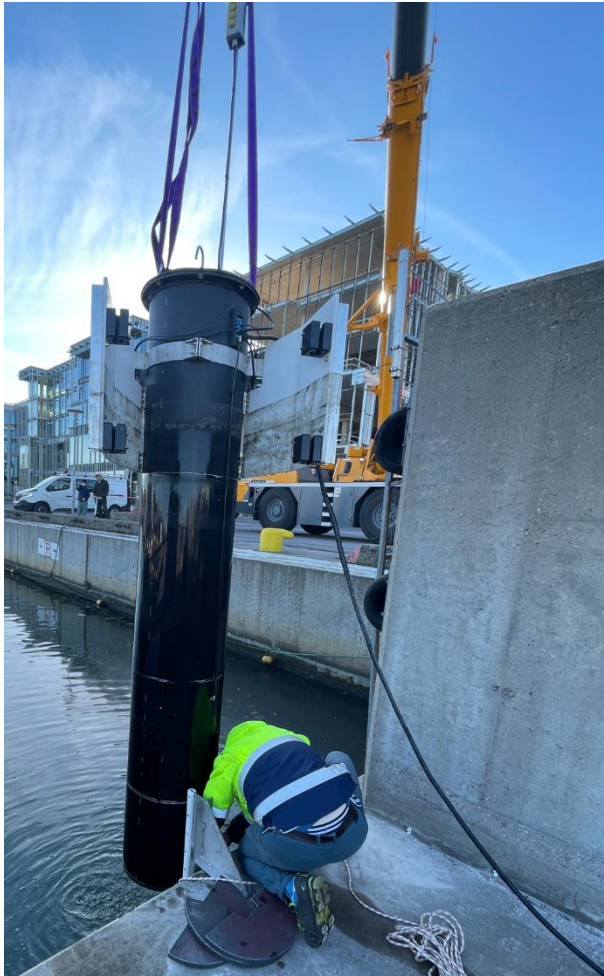
Joonis 30. Laadimisjaama paigaldustööd. Fotod: Mindchip
