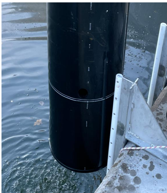
Joonis 25. Kaipoolsed metallkonstruktsioonid. Foto: Mindchip
