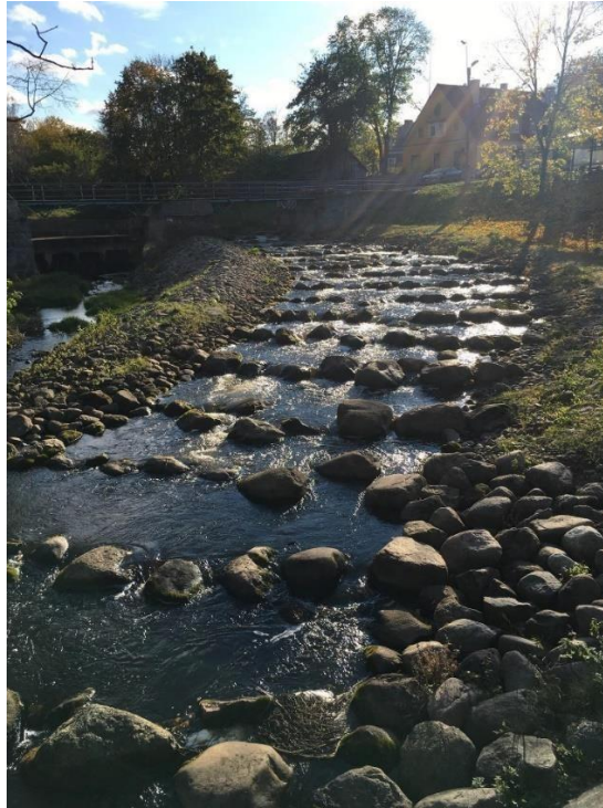
Joonis 19 Kose-Veskijärve kalapääs
