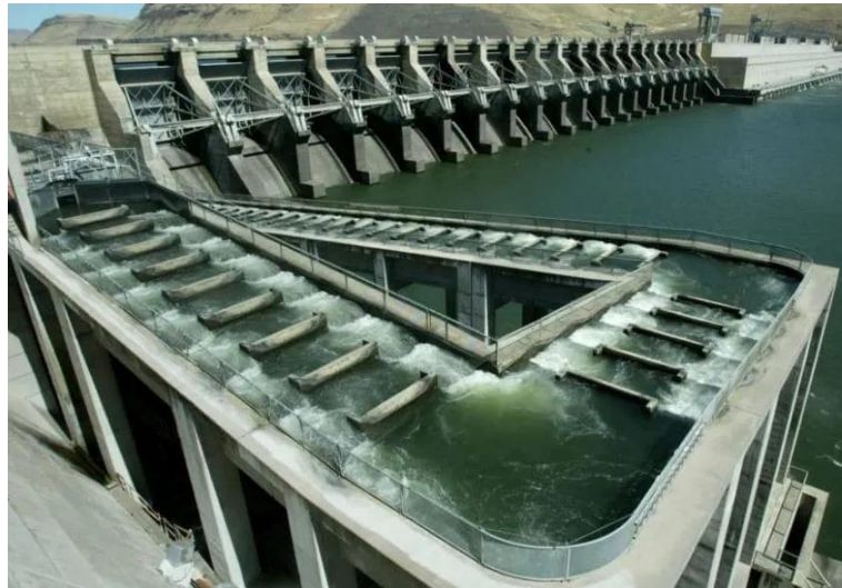
Joonis 9 Tõkiskalapääs Elbe jõel Saksamaal [26]
