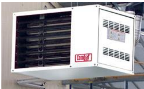
Sele 4.1. Gaasiküttel otsetoimeline soojaõhukalorifeer. [20]
