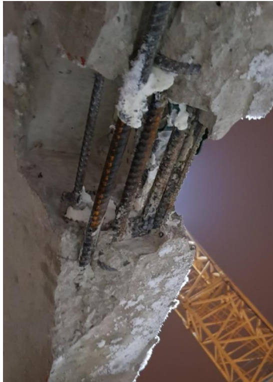
Joonis 5.29 Tapi ava läbiv armeering (Foto autor: objektiinsener T. Stern)
