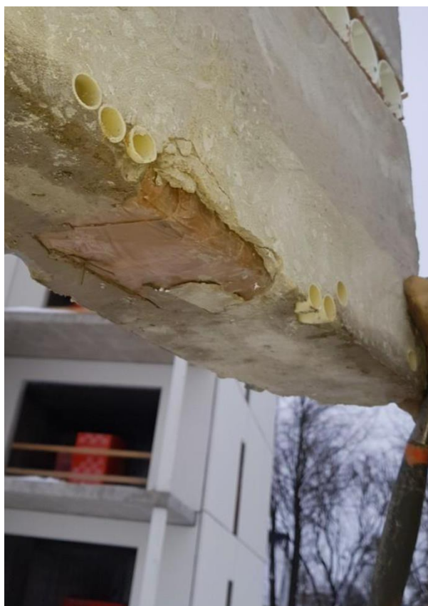
Joonis 5.30 Puhastamata tapivarda ava (Foto autor: objektiinsener T. Stern)
