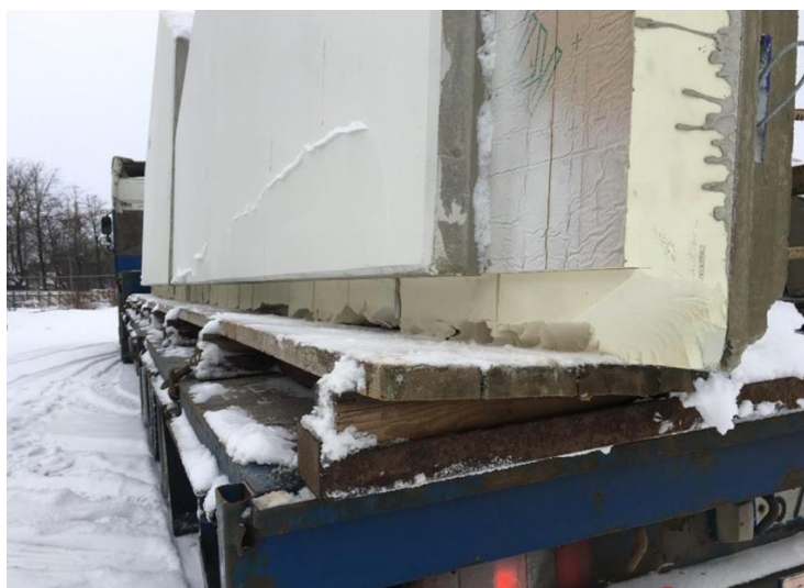
Joonis 5.24 Tehasest saabunud raudbetoonist seinaelement (Foto autor: objektiinsener T. Stern)
