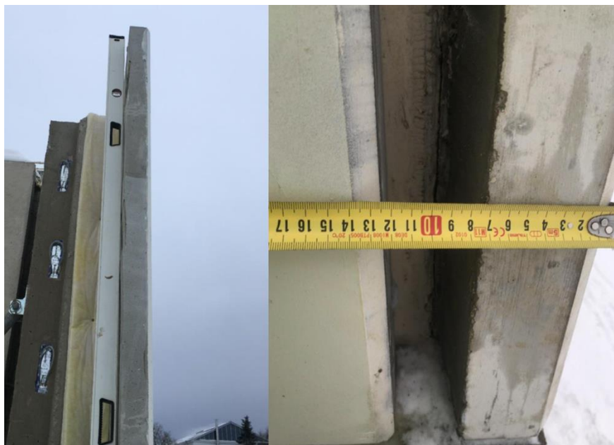
Joonis 5.26 Väliskooriku mõõtmete muutus (Fotode autor: objektiinsener T. Stern)
