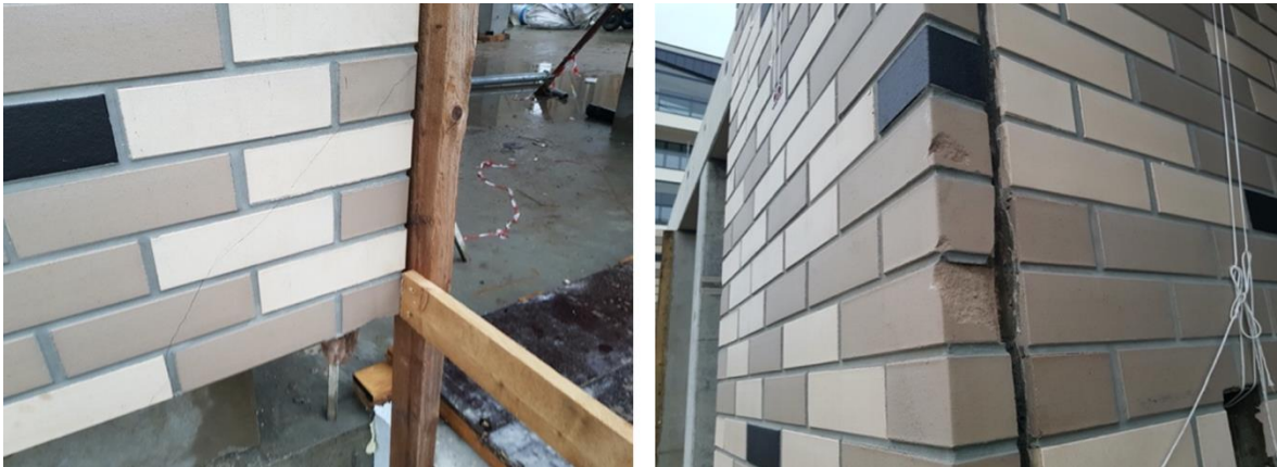
Joonis 5.35 Tellisplaatide puudused (Vasakul: pragunenud tellisplaadid, paremal: purunenud tellisplaadid) (Fotode autor: A. Gildi)
