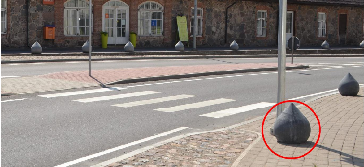
Foto L9.1 Betoontilgad kõnnitee servas [21]
