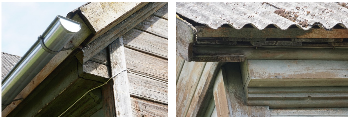
Joonis 4.3 Vana hooneosa räästakarniis ja osa katuse kihtidest. Fotod Ü. Alev 05.05.2022
