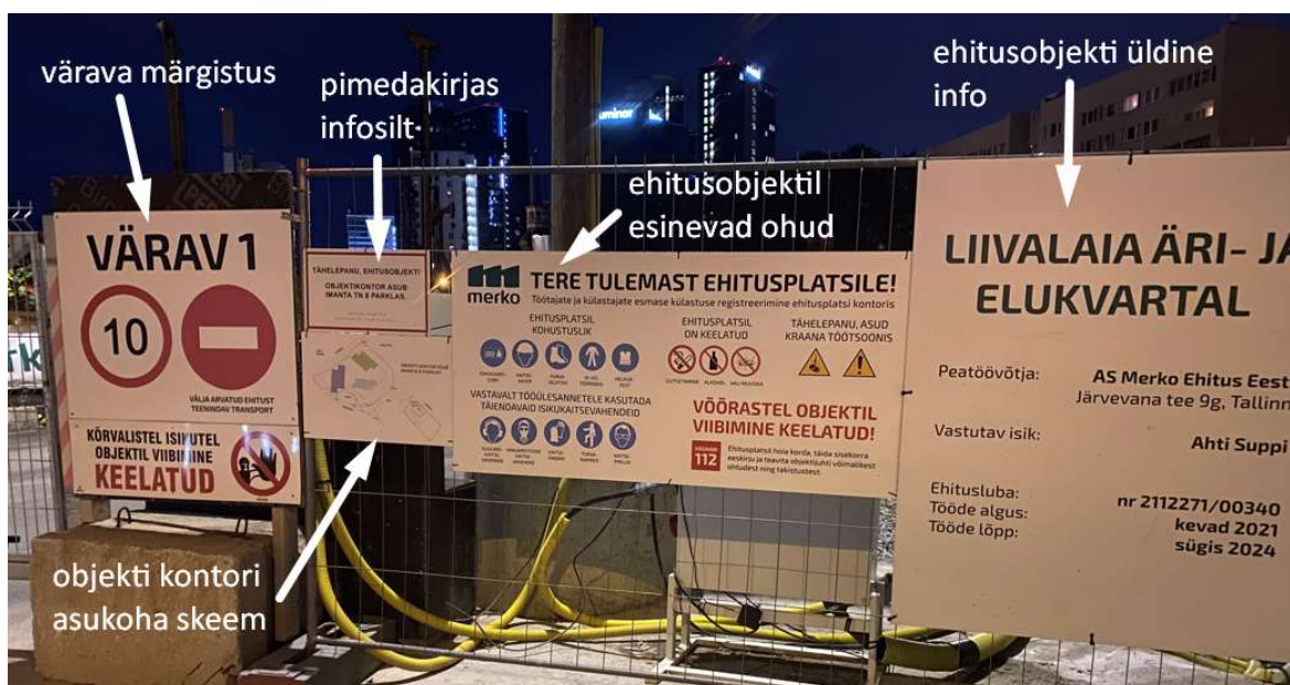
Joonis 3.14 Objekti sissepääsu märgistus
