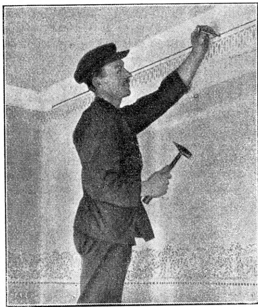
Ülesseatud nõõri järgi tööline teeb auke nõõrtüüblite jaoks.
