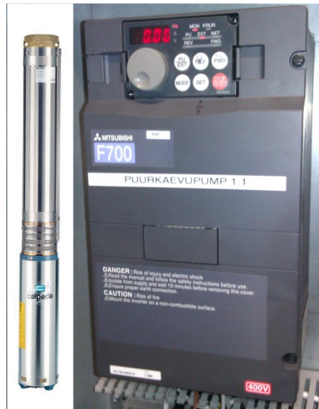
Sele 3.2 Veepump Calpeda SD [9] vasakul ja sagedusmuundur F700 paremal
