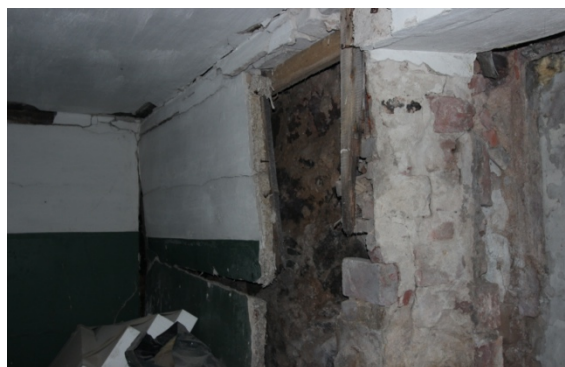
Joonis 3.6 TEP plaatidega kaetud keldri välissein (autori foto)
