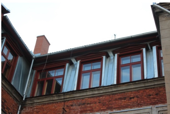
Joonis 3.46 Korrektsed hoovikülje mansardkorruse aknad (autori foto)
