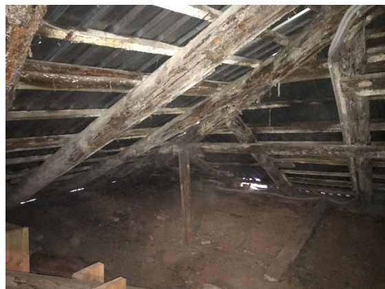
Joonis 3.21 Lõunakülje ebakorrektsed roovid (autori foto)
