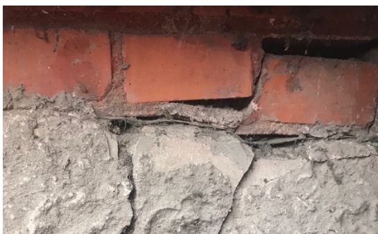
Joonis 3.3 Vajumispraod luugiga keldrissepeäsu kohal (autori foto)
