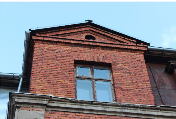
Joonis 3.13 Esifassaadi kolmnurkne viil (autori foto)
