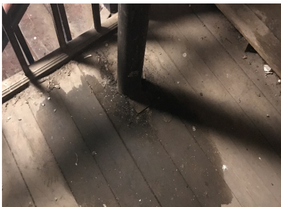
Joonis 3.20 Leke pööningul asetseva metallposti juures (autori foto)
