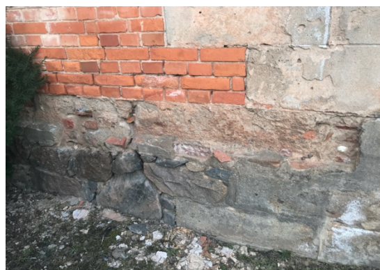
Joonis 3.10 Murenenud ja lahtiste kividega sokkel (autori foto)
