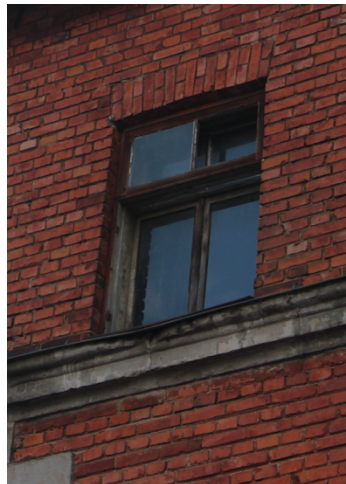
Joonis 3.35 Kolmanda korruse aken (autori foto)
