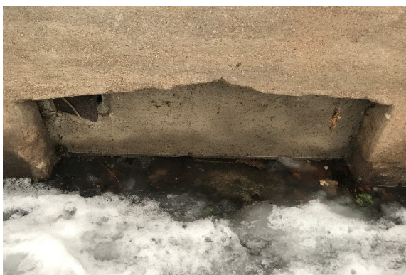
Joonis 3.9 Veelomp kinni müüritud lõunafassaadi akna kohal (autori foto)
