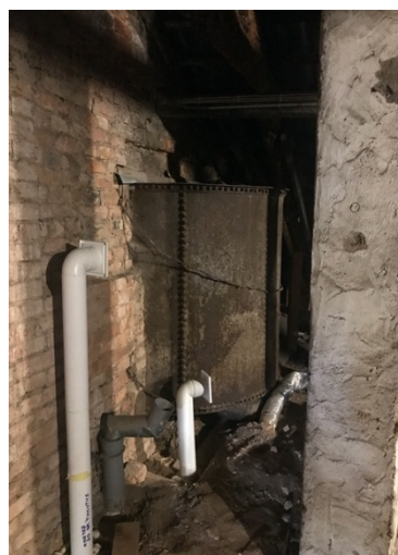
Joonis 3.62 Pööningul paiknevad tuulutuskorstnad (autori foto)
