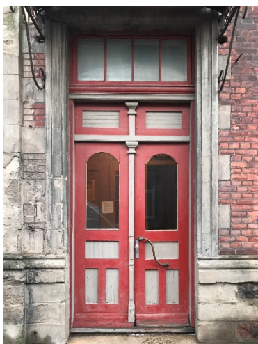
Joonis 3.27 Välisuks VU-2 (autori foto)
