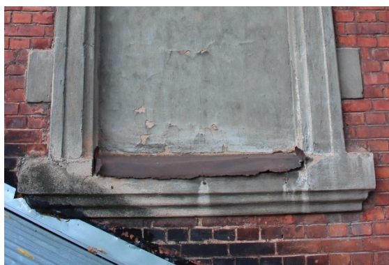
Joonis 3.24 Lõunafassaadi petikakna plekk (autori foto)
