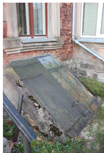
Joonis 3.33 Keldriluuk (autori foto)
