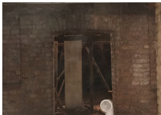
Joonis 3.19 Pööningu tellismüür (autori foto)
