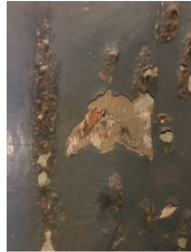
Joonis 3.57 Ukselt paistvad alumised viimistluskihid (autori foto)
