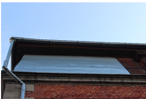
Joonis 3.23 Põhjafassaadi mansardpleki parandus (autori foto)
