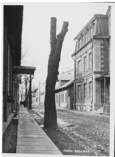
Joonis 2.7 Hoone põhjapoolne serv enne 1945. aastat [14]
