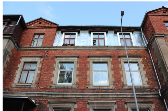
Joonis 3.14 Esifassaadi krohvraamistus (autori foto)
