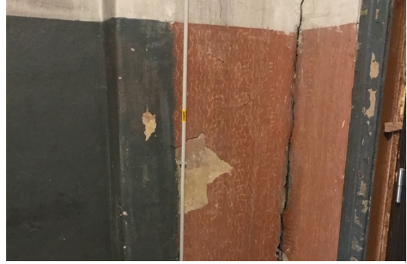
Joonis 3.54 Läbiv pragu koridori seinas (autori foto)
