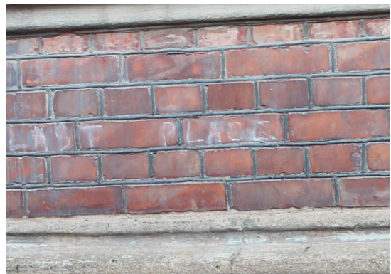
Joonis 3.12 Kumervuugiga müüritis (autori foto)
