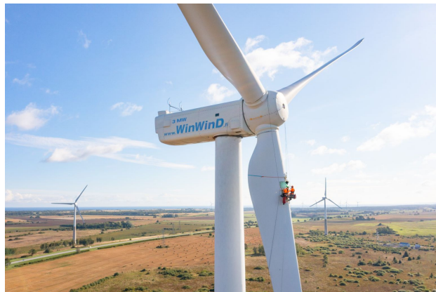
Joonis 8: Tuuliku labadel teostatavad tööd "rope-access" meetodil. Allikas: Enefit Green.
