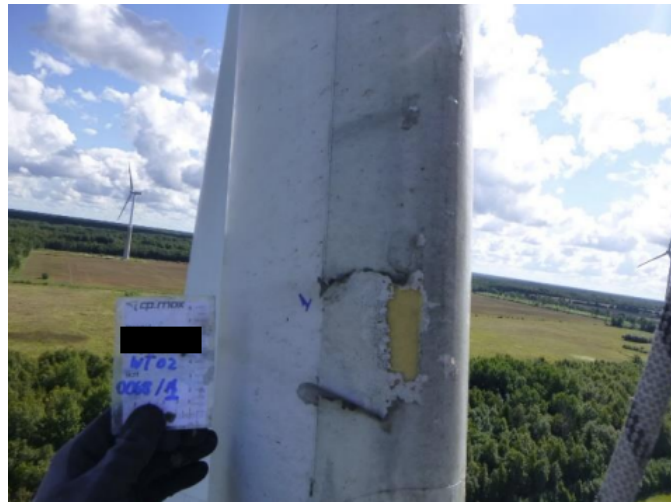
Joonis 29: Esiserva erosioon tuulikulabal. Allikas: Enefit Green.
