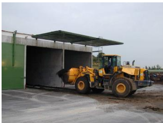
Joonis 1.4 Garaaži tüüpi perioodiline reaktor [12]
