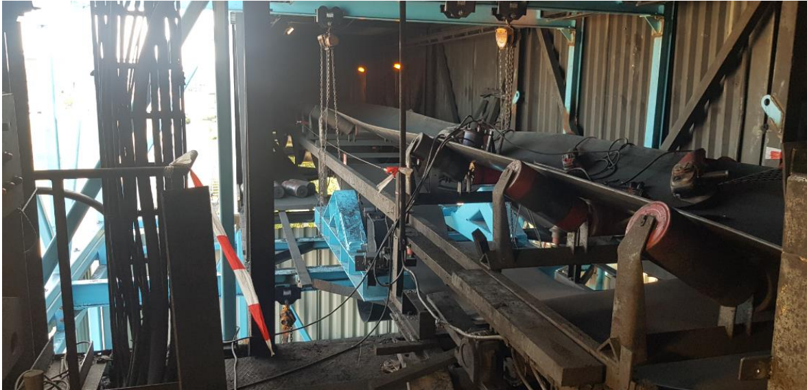
Sele 4.2 Konveieri pingutussüsteemi paigaldus
