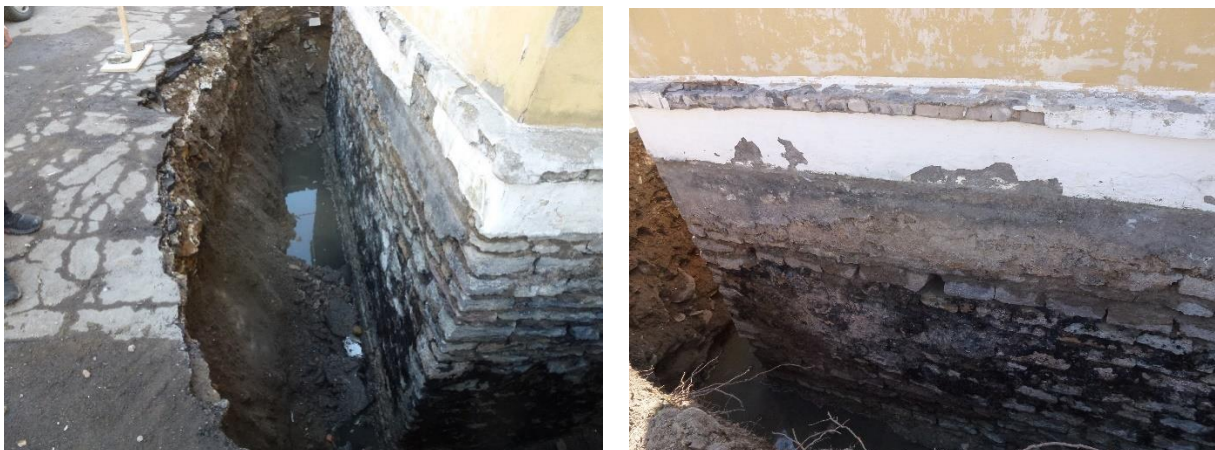
Foto 3.1 Vundament ja sokliosa
