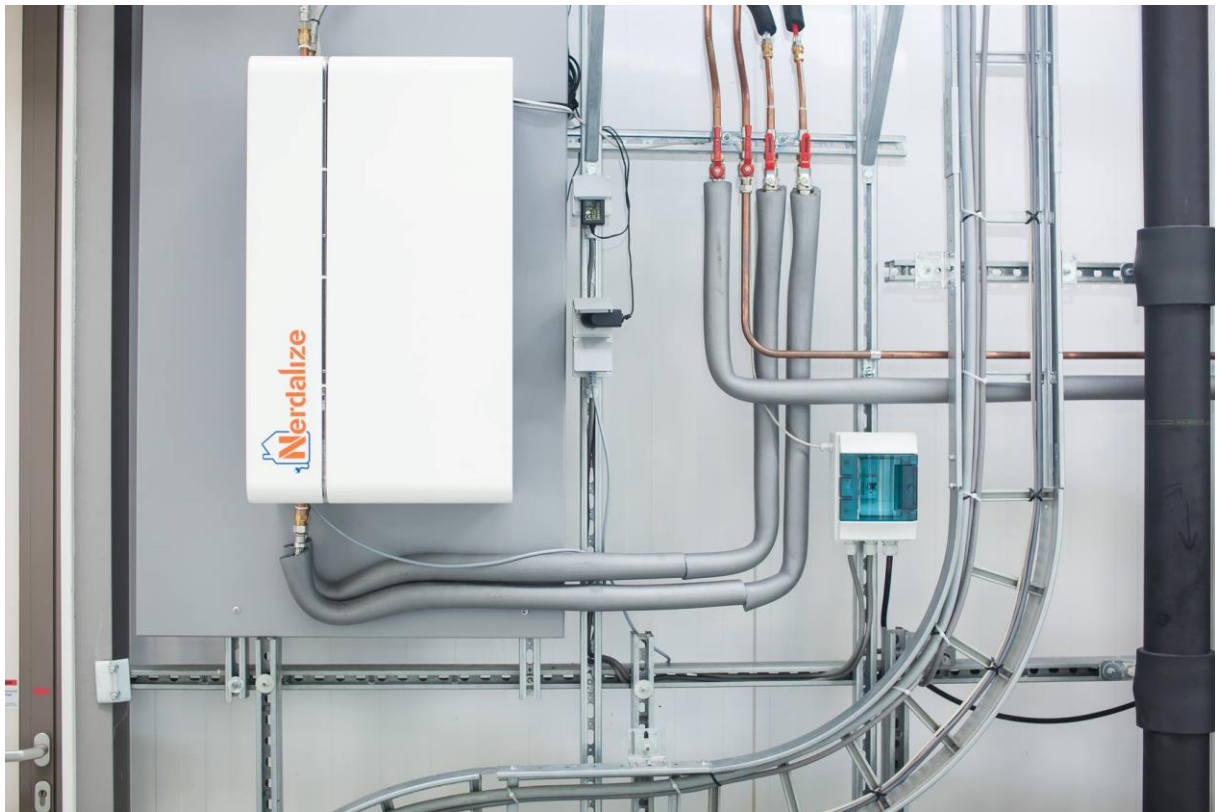
Joonis 4. Nerdalize serverimoodul, mis toodab kuuma tarbevett
