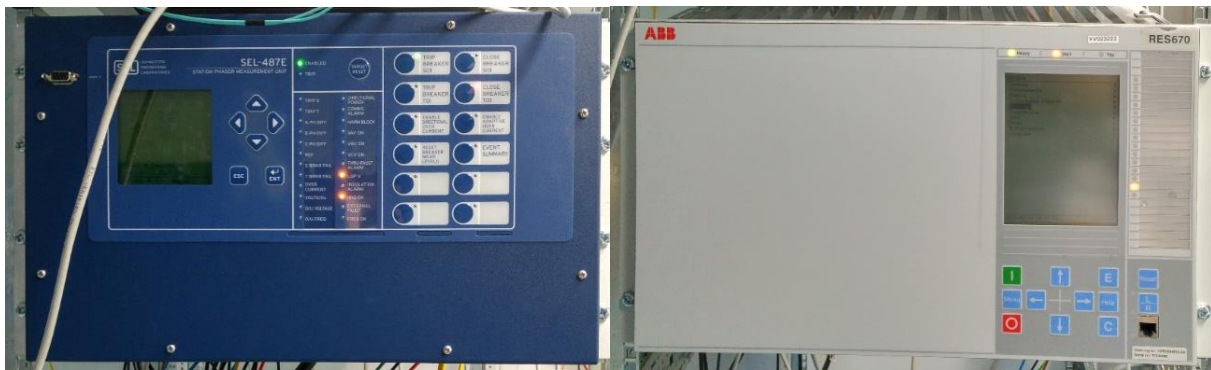
Joonis 2.12. Katsetatud füüsilised faasimõõteseadmed: PMUA (vasakul) ja PMUB (paremal)
