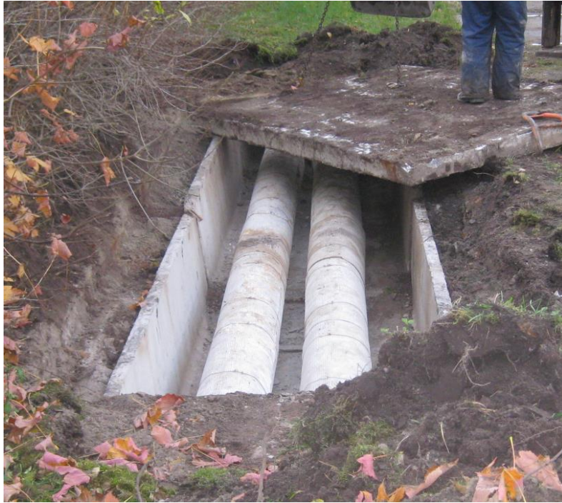
Joonis 2.1 Raudbetoonkanalis torustik [10]
