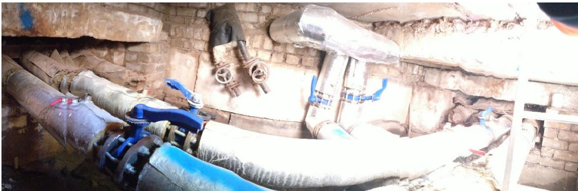
Joonis 2.2 Raudbetoonkanalis torustiku kamber [10]
