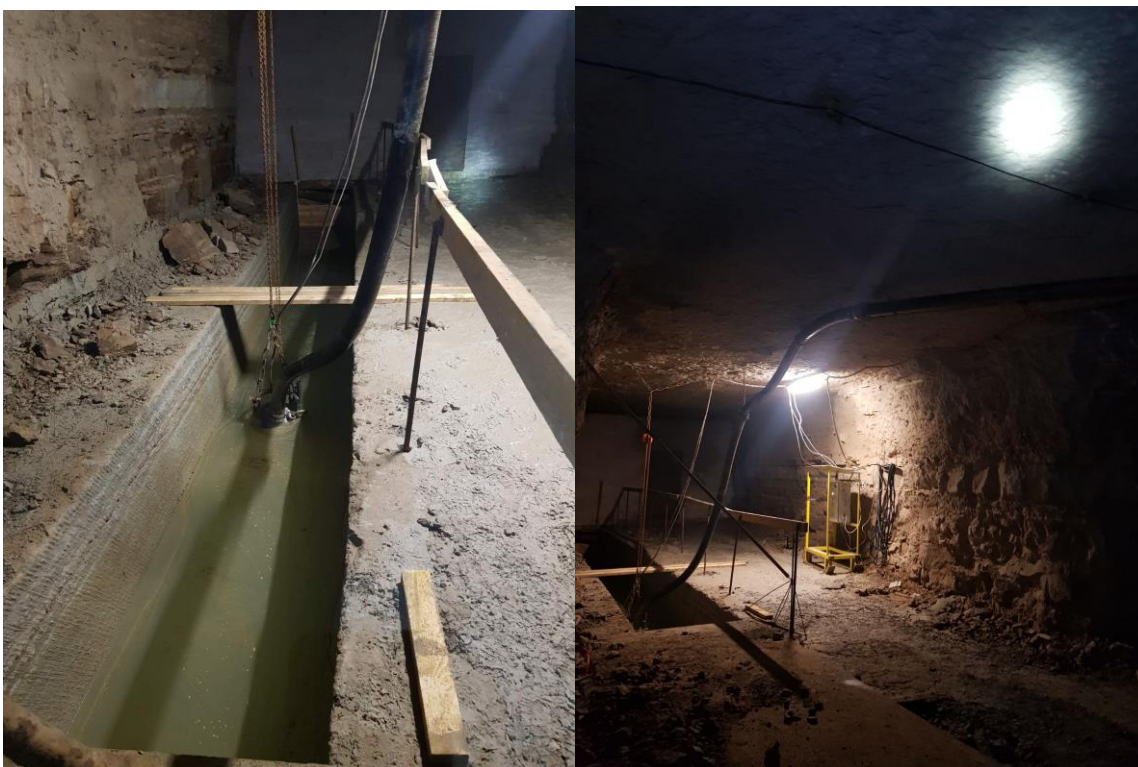
Joonis 3.1 lokaalne veekõrvaldus (Ojamaa kaevanduse kamberploki nr 22 külgstrekk)
