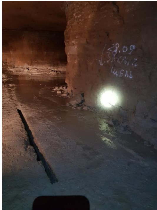
Joonis 3.2 Veekõrvalduskraav (Ojamaa kaevandus)
