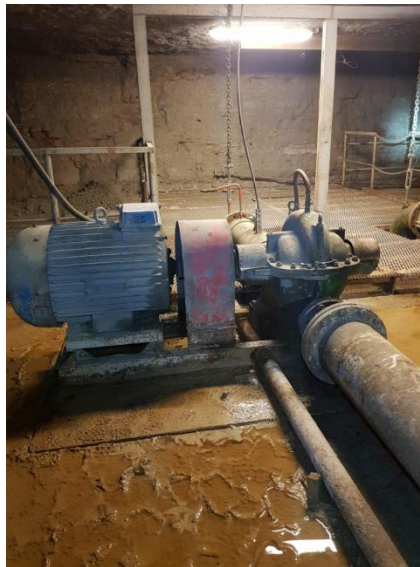
Joonis 4.12 Tsentrifugaalpump Ojamaa kaevandus
